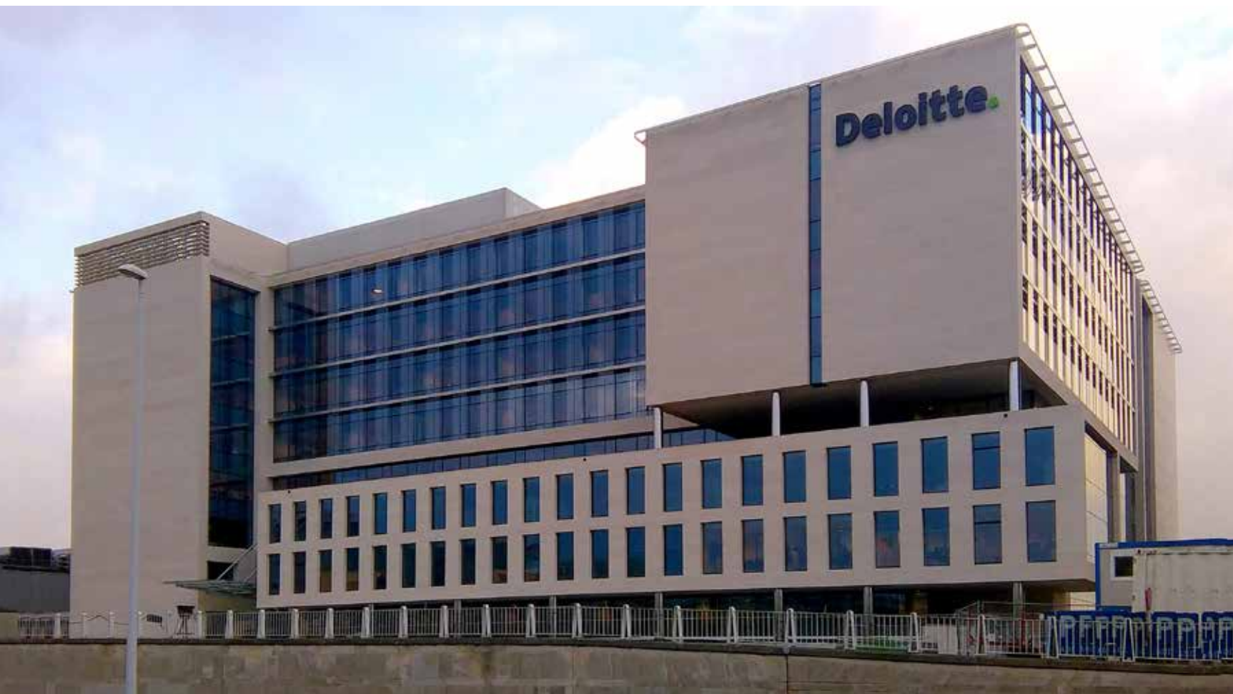
Het oude kantorencomplex op en rond de oude terminal 58 is gedeeltelijk gerenoveerd en omgetoverd tot een standingvol en ultramodern gebouw.
