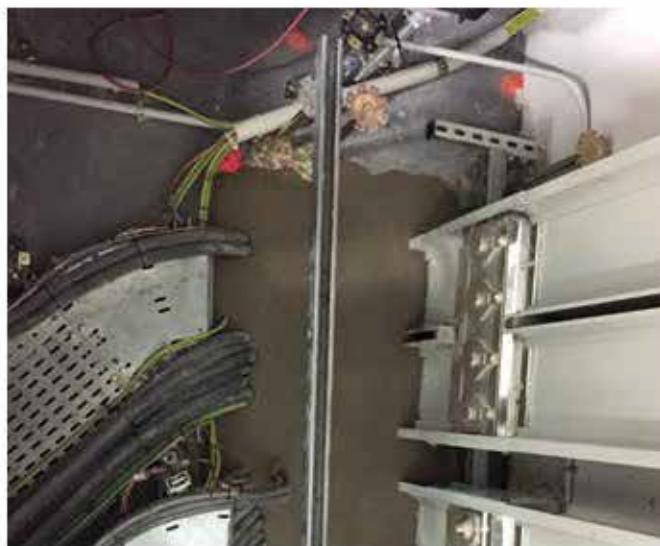
De brandvrije massa van Bio Benelux, NOVASIT BM, zorgt voor een vuurbestendige en rookgasdichte harde afdichting.
