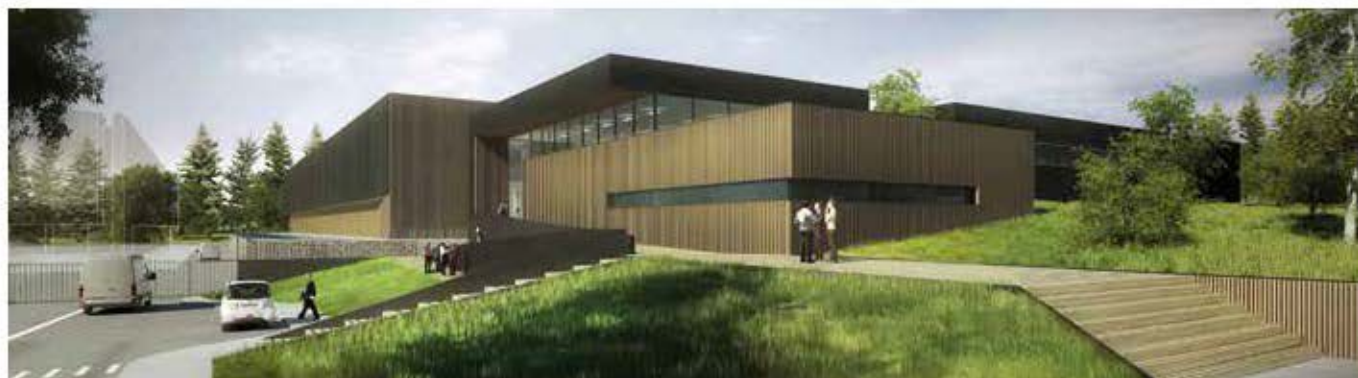
Het nieuwe datacenter van BNP Paribas Fortis in Vaux-sur-Sûre. Samen met dat van Bastogne zal het project op termijn meer dan 50.000 vierkante meter innemen. (© Enia Architects)
