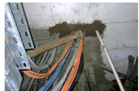
De doorvoeringen werden brandwerend gedicht met BIO-brandvrije mortel Novasit K2. © Bio Benelux
