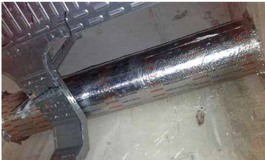
Elke doorvoering werd brandwerend gedicht door Bio Benelux © Bio Benelux
