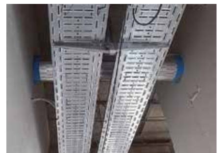
Bio Benelux staat in voor het brandwerend afdichten van alle bouwelementen. © Bio Benelux
